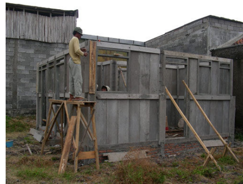
Gambar 14. Pemasangan komponen (Sumber : Proceeding ICBS dan Dokumentasi Bpk. Andry Widyowijatnoko)
