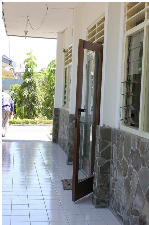
Gambar 6.5. Foto Bangunan SMPLB A YPAB yang kurang aksesibel (Sumber: Dokumentasi Tanuwidjaja, dkk, 2012)
