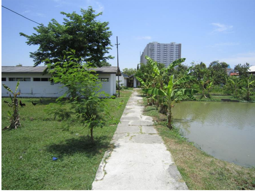
Gambar 6.10. Foto Bangunan SMPLB A YPAB yang kurang aksesibel (Sumber: Dokumentasi Tanuwidjaja, dkk, 2012)
