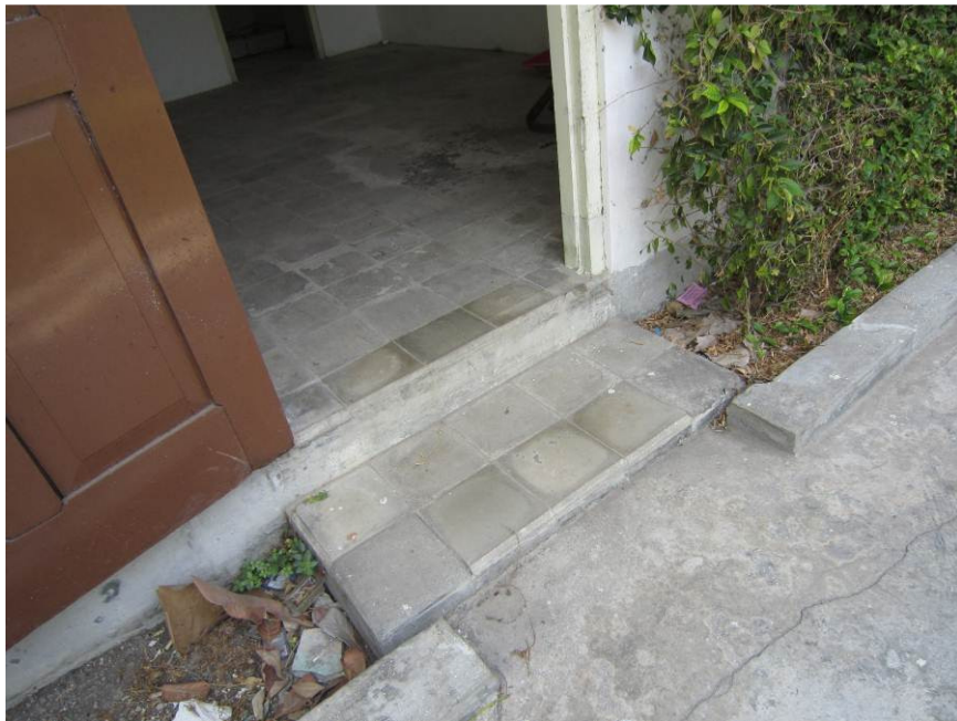
Gambar 6.7. Foto Bangunan SMPLB A YPAB yang kurang aksesibel (Sumber: Dokumentasi Tanuwidjaja, dkk, 2012)
