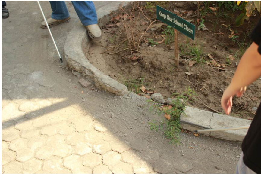
Gambar 6.6. Foto Bangunan SMPLB A YPAB yang kurang aksesibel (Sumber: Dokumentasi Tanuwidjaja, dkk, 2012)
