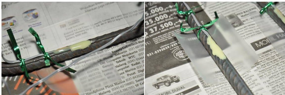
Gambar V-15 Aplikasi Coating untuk pelindung strain gauges.
