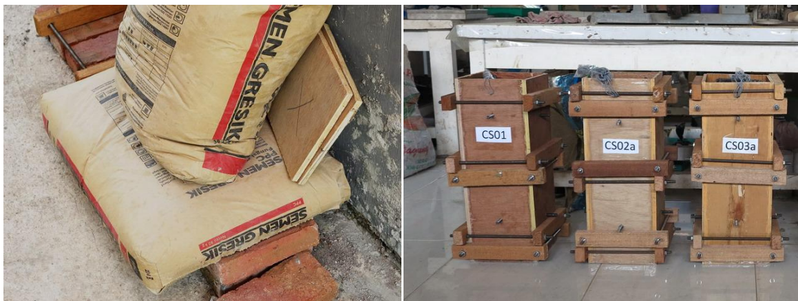
Gambar V-23 Material semen dan bekisting yang dipersiapkan.
