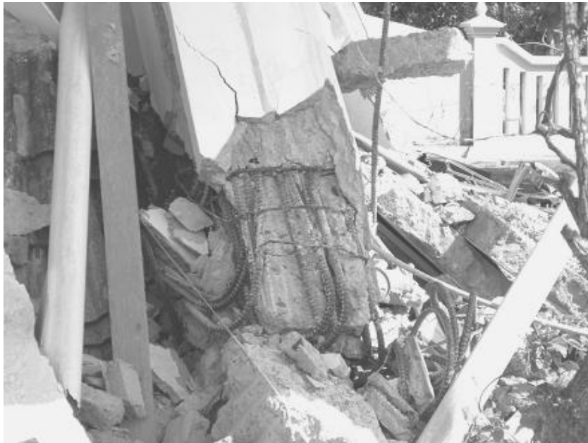
Gambar I-2 Kegagalan kolom karena minimnya sengkang pada gempa Jogja 2006
