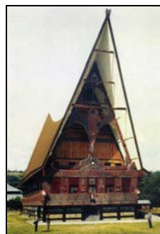
Gambar 05. Serambi Depan & Gorga pada Fasad Bangunan GKIP (Sumber: Dokumentasi PML Yogyakarta)
