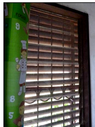
Gambar 16. Jendela nako pada Perpustakaan yang dilengkapi dengan sirip
