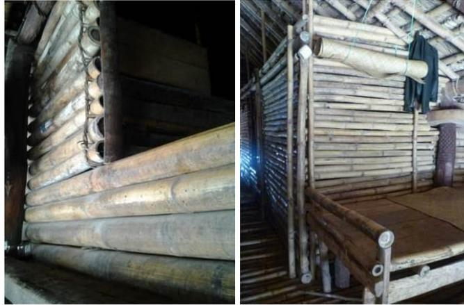
Gambar 4. 21 Susunan bambu bulat pada elemen dinding di Tarung (kiri) dan Ratenggaro (kanan)
