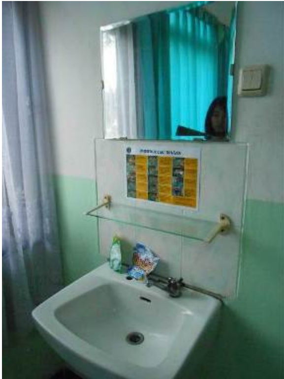
Gambar 4.28. Foto Wastafel di Ruang Rawat Inap Kelas II di Paviliun RS X
