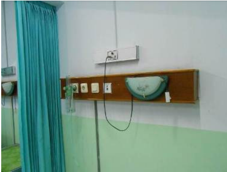
Gambar 4.18. Foto Ruang Rawat Inap Kelas III di Paviliun RS X
