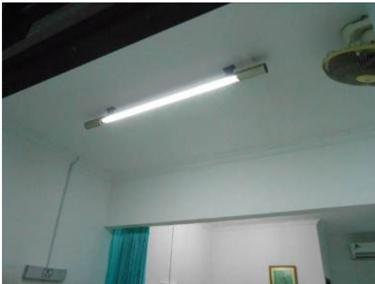
Gambar 4.19. Foto Penerangan di Ruang Rawat Inap Kelas III di Paviliun RS X
