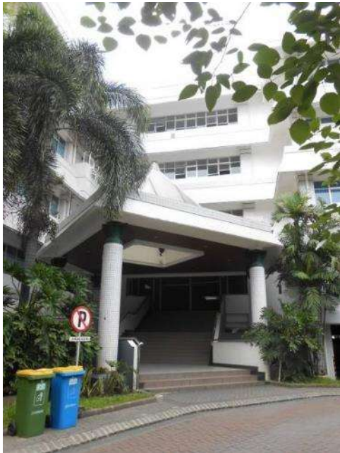
Gambar 7. Tangga utama Gedung T sebagai Landmark yang menarik.
