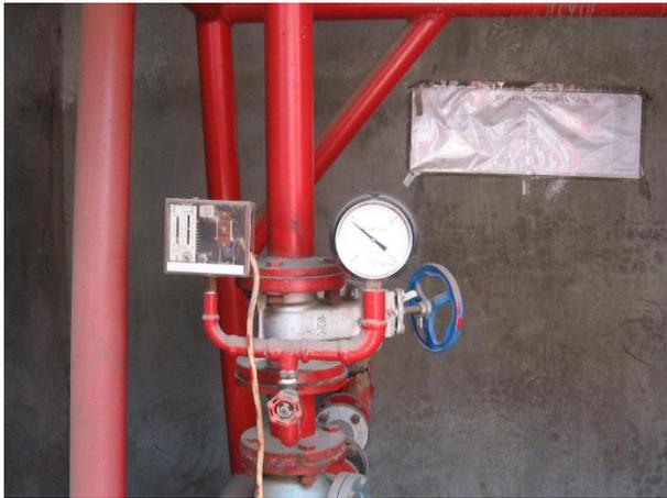
**Gambar 2.** *Pressure gauge* pada Reservoir Tekan Pipa Hydrant
