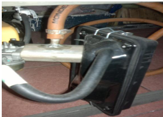
Gambar 3. Realisasi dan Pemasangan Alat Konversi Electric Generator Biogas Fuel
