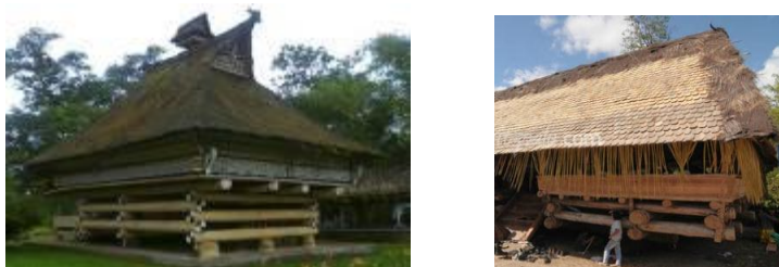
Gambar 9. Struktur utama dengan susunan balok melintang pada karya arsitektur Batak Karo dan Lobo menunjukkan nilai kesemestaan.
