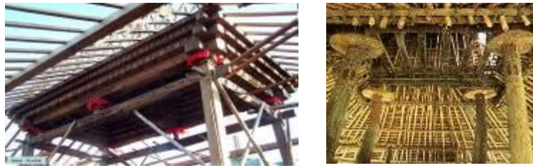
Gambar 7 pertemuan antara kolom dan balok, perhatikan pada cara penyelesaian yang berbeda, yang secara ornamental memperlihatkan keindahannya masing-masing.
