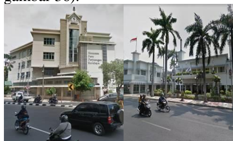
Gambar 36. Preservasi Konservasi Sumber: Monumen Pers dan Hotel Majapahit (Google Street View)
