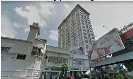
Gambar 29. Sisi utara (Hotel Swiss Bell) Sumber: Jl Tunjungan (Google Street View)
