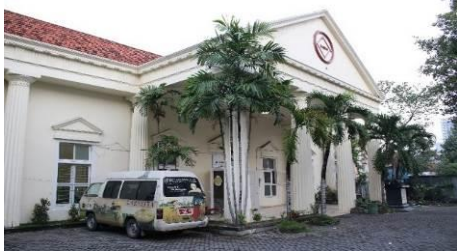
Gambar 27. Sisi Tengah (Gedung BPN) Sumber: Dokumentasi Bramasta, 2014
