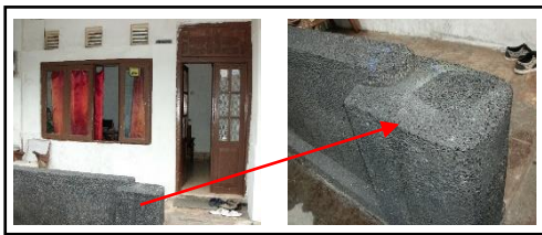
Gambar 3. Balustrade dari beton cor
