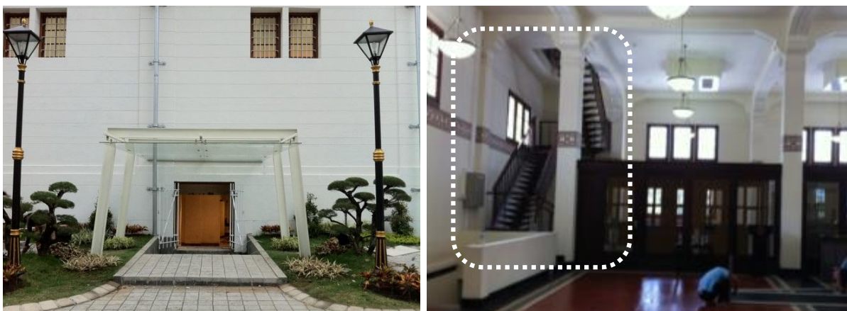
Gambar 12. Salah satu contoh elemen baru dengan material modern: pintu masuk Selatan dengan material baja dan kaca (kiri), tangga ke lantai 2 dengan bahan baja (kanan).
