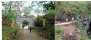
Gambar 13. Jembatan (Sumber: Dokumentasi Pribadi)
