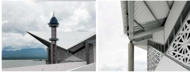
Gambar 10. Bagian badan masjid yang didominasi kolom kolom ekspos sebagai pembatas terasan (Sumber: https://www.arsitag.com/project/masjid-apung-amahami , diakses Juli 2021)
