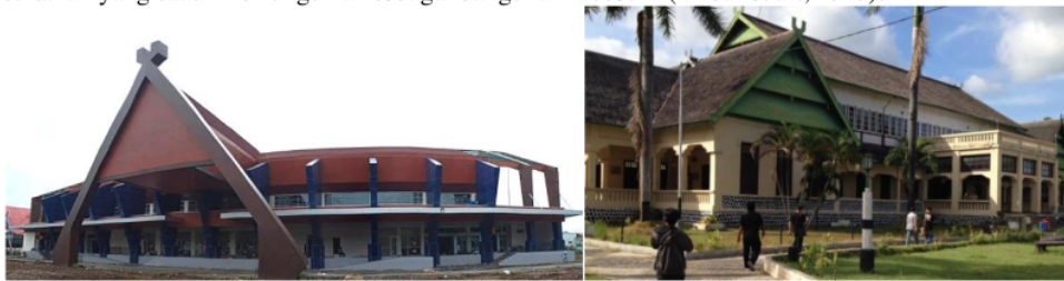
Gambar 4. Penerapan repetisi kolom kolom struktur pada bagian badan bangunan (Sumber: http://www.peloporntb.com/2021/02/terminal-mewah-bandara-sms-bima-kian.html , diakses Juli 2021)
