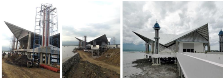
Gambar 11. Penerapan unsur panggung pada bagian kaki masjid yang berbatasan langsung dengan perairan (Sumber: https://www.arsitag.com/project/masjid-apung-amahami , diakses Juli 2021)
