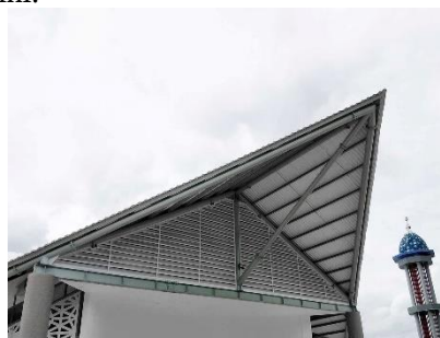
Gambar 9. Gevel atap bersirip yang terinspirasi dari gevel atap bangunan banguna di Bima
