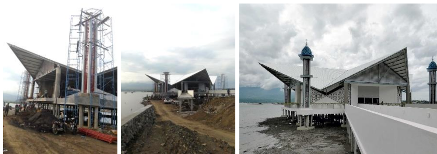
Gambar 11. Penerapan unsur panggung pada bagian kaki masjid yang berbatasan langsung dengan perairan
