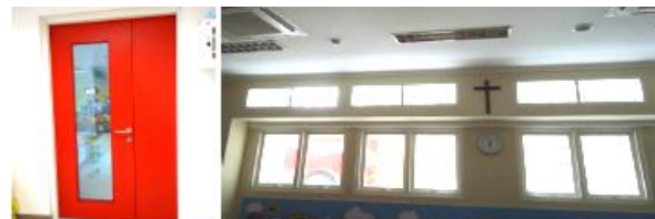
Gambar 6. Pintu dan jendela pada ruang belajar dan bermain di TK Kr. Petra 7
