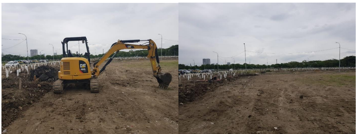
Gambar 3. Lokasi lahan di bagian belakang yang masih luas sedang diratakan
