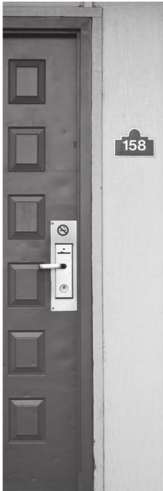
Gambar 30. Pintu Ramah Penderita Demensia
