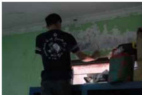
Gambar 2. Pengikisan Dinding
