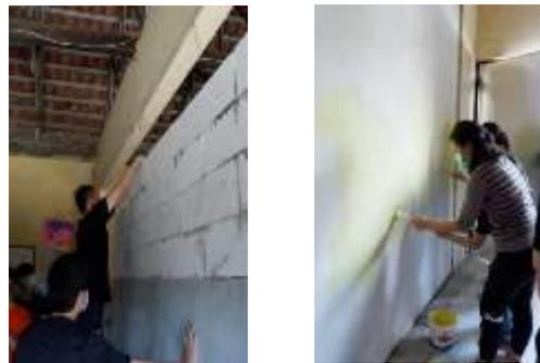
Gambar 5. Pembuatan dinding pembatas kelas dari bata ringan
