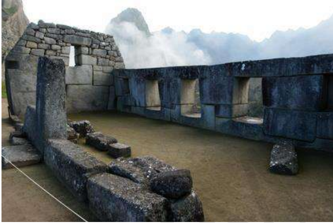
Gambar 121a. Dinding Gevel Bagian Puncak Runtuh
