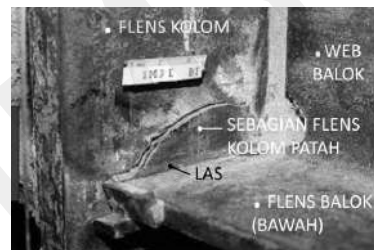
Gambar 66c. Retak pada Sebagian Flens Kolom di Belakang Las, Sebagian Flens Kolom Tetap Melekat pada Flens Kolom di A
