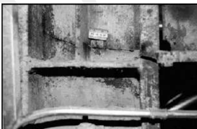
Gambar 66d. Patah pada Flens Kolom di A
