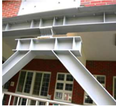
Gambar 107. Contoh Penerapan ADAS pada Chevron Braced-Frame http://article.sapub.org/image/10.5923.c.jce.201402.33_017.gif , diunduh Juni 2022
