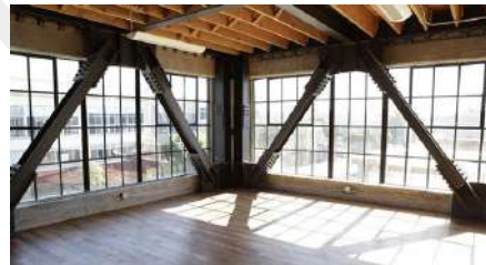
Gambar 141. Retrofitting Sebuah Kantor 4 Lantai di San Francisco dengan Eccentrically Braced-Frame
