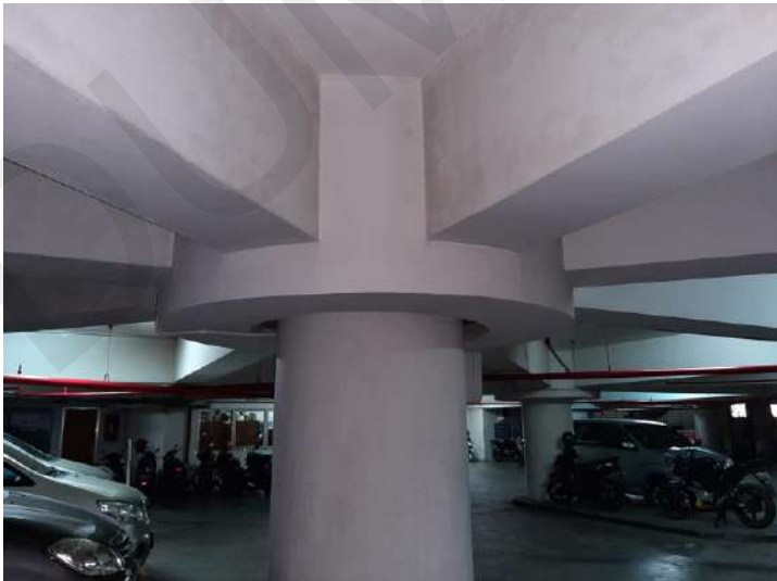
Gambar 148. Kepala Kolom Gedung P U.K.Petra, Surabaya
