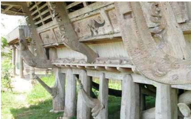
Gambar 125c. Tiang di Atas Umpak Tanpa Ikatan Rumah Omo Sebua
