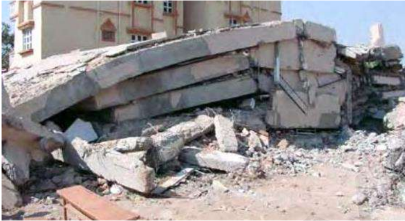
Gambar 47b. Keruntuhan Total Bangunan Karena Mekanisme “Pancake”
