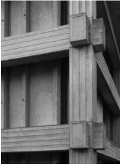
Gambar 150. Detail Pertemuan Kolom-Balok
