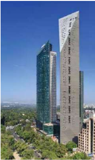
Gambar 138e. Tampilan Beton dari Arah Belakang Reforma
