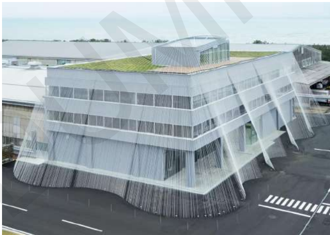
Gambar 142b. Bangunan Fa-bo Sesudah Retrofit
