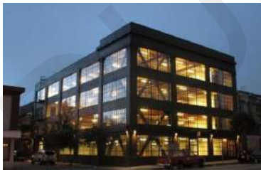
Gambar 141. Retrofitting Sebuah Kantor 4 Lantai di San Francisco dengan Eccentrically Braced-Frame
