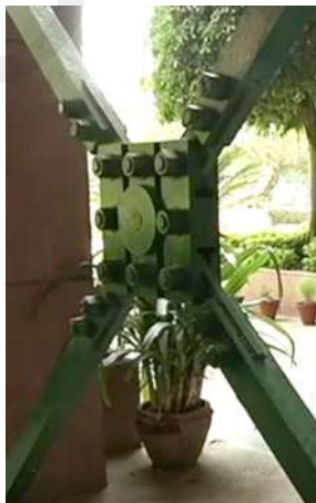
Gambar 102c. Cross-Bracing Friction Damper Terpasang pada Bangunan
