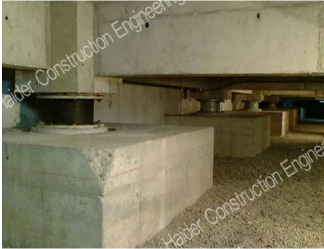
Gambar 91b. Contoh Penempatan Base-Isolation di Dasar Kolom
