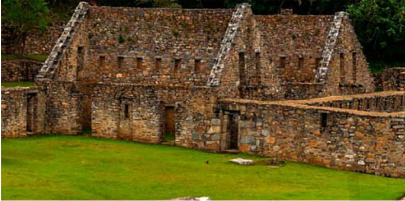
Gambar 121c. Dinding Gevel dengan Dinding Penahan
