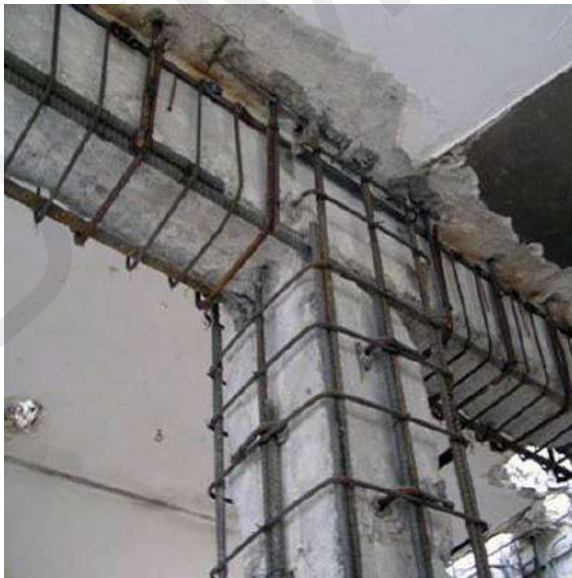
Gambar 132b. Penguatan Kolom dan Balok Beton Bertulang
