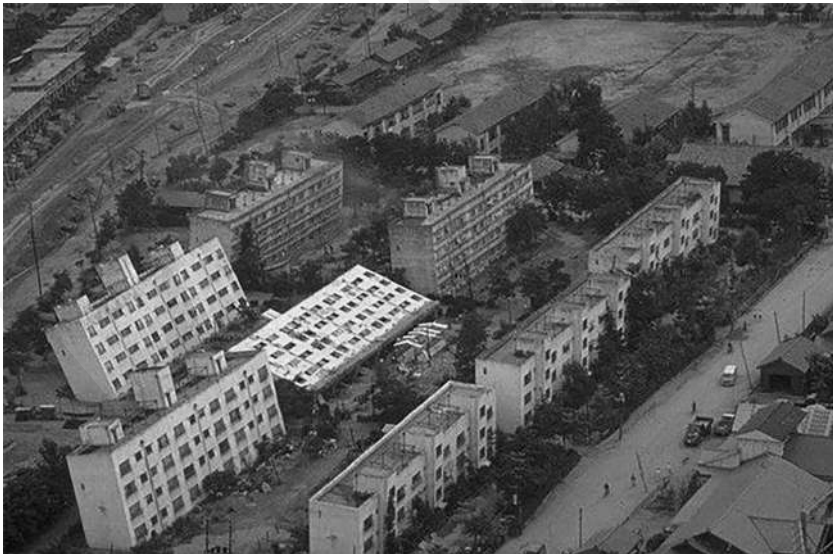
Gambar 7a. Bangunan-bangunan Runtuh Karena Fenomena Liquefaction di Niigata Prefecture Jepang
