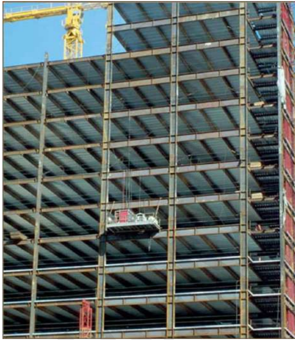
Gambar 65. Struktur Rangka Pemikul Momen Baja
