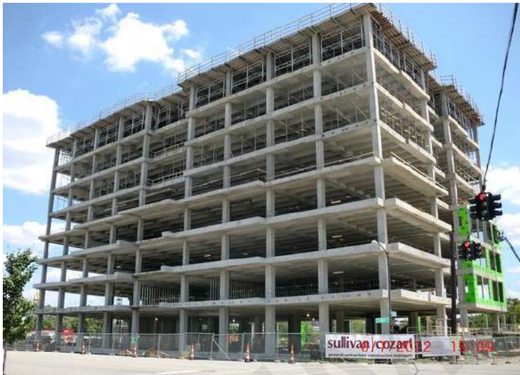
Gambar 57. Contoh Konstruksi Bangunan RPM Beton Bertulang
