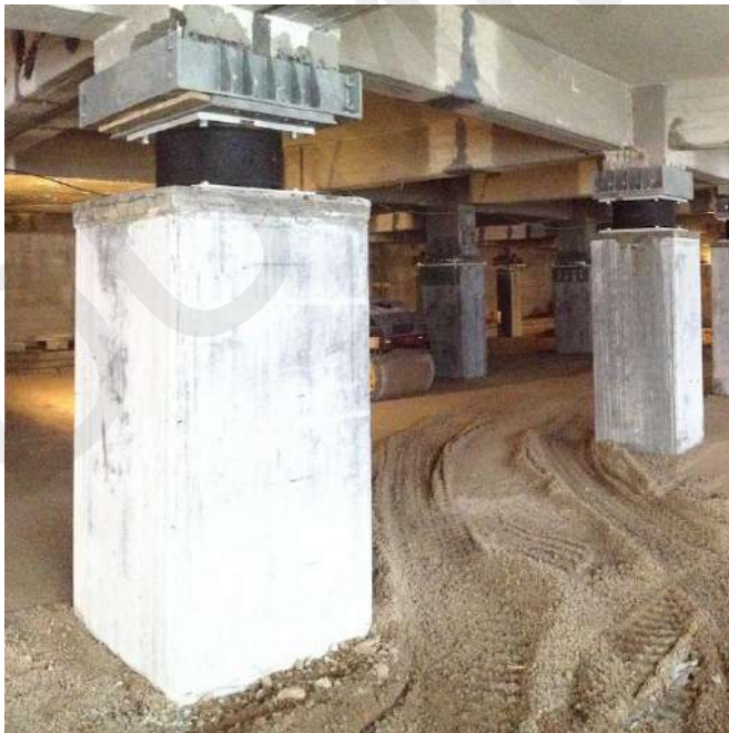
Gambar 91c. Contoh Penempatan Base-Isolation di Puncak Kolom Basement
