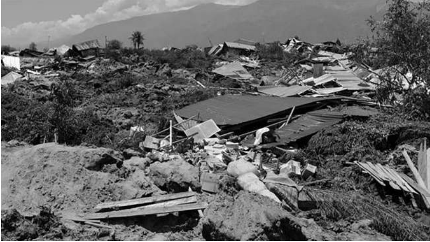
Gambar 7b. Bangunan-bangunan Tenggelam Karena Fenomena Liquefaction Tahun 2018 di Palu, Indonesia
