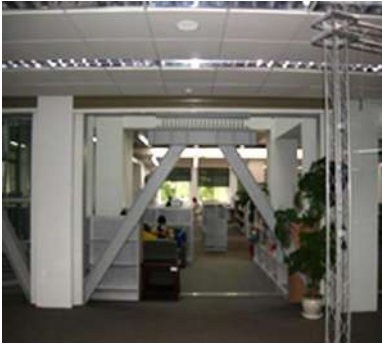
Gambar 107. Contoh Penerapan ADAS pada Chevron Braced-Frame http://article.sapub.org/image/10.5923.c.jce.201402.33_017.gif , diunduh Juni 2022
