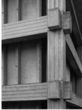
Gambar 150. Detail Pertemuan Kolom-Balok
