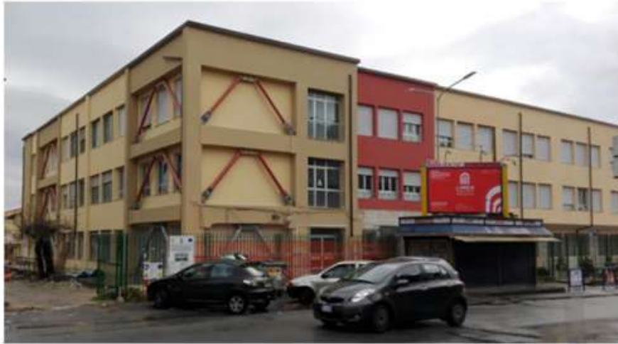
Gambar 145. Tampilan Eksterior Bangunan Sekolah di Vibo Valentia Italia Setelah Retrofit
