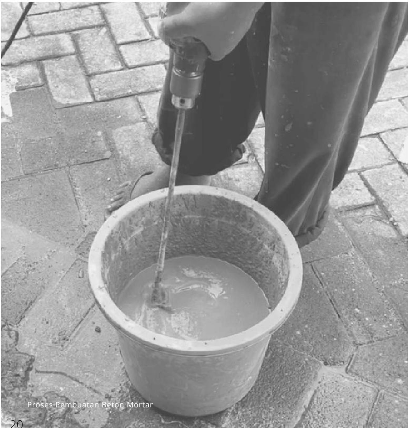
Proses Pembuatan Beton Mortar
