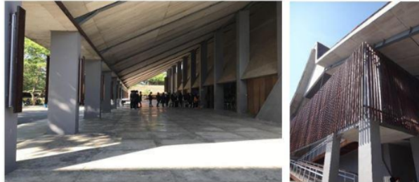
Gambar 19: kiri, kolom dan balok dengan material beton dan baja pada hall aula. Kanan, fasad batangan kayu ulin
