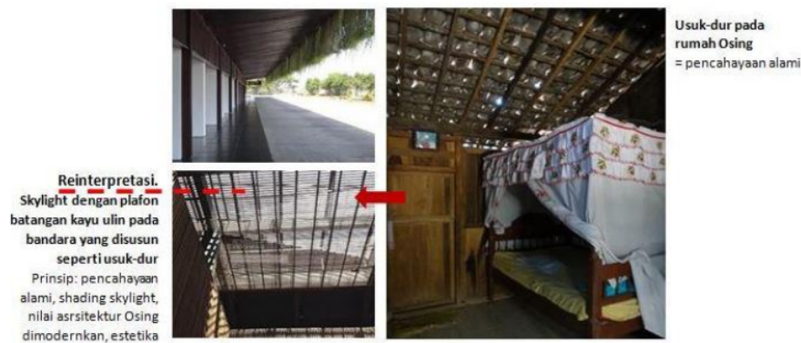
Gambar 13 : kiri, plafon kayu ulin bekas pada Bandara Banyuwangi. Kanan, rangka atap ekspos pada rumah Osing Kemiren.
