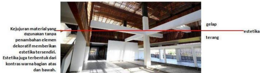
Gambar 15 : sistem struktur dan plafon Bandara Banyuwangi Sumber: Analisa Pribadi, 2023
