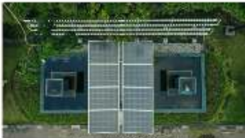
Gambar 10. PLTS Off Grid terpasang atas
