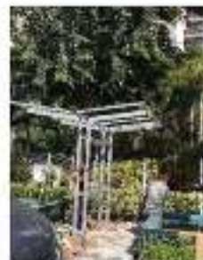
Gambar 7. Kerangka besi hollow untuk penyangga panel surya
