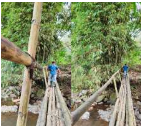
Gambar 10. Kondisi eksisting jembatan
