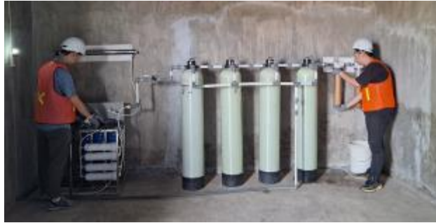
Gambar 5. Pemasangan alat ALPAMAL pada hari pelaksanaan
