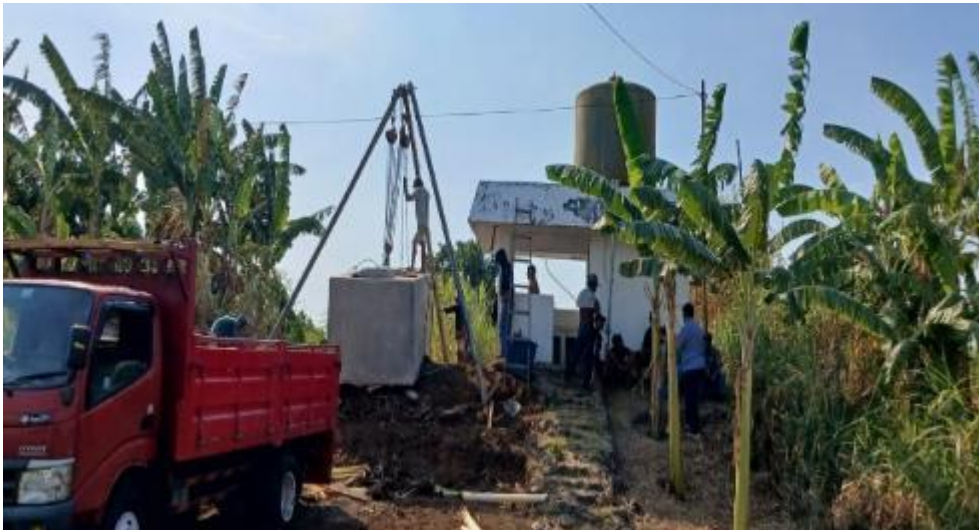
Gambar 5. Pemasangan Tandon Air
