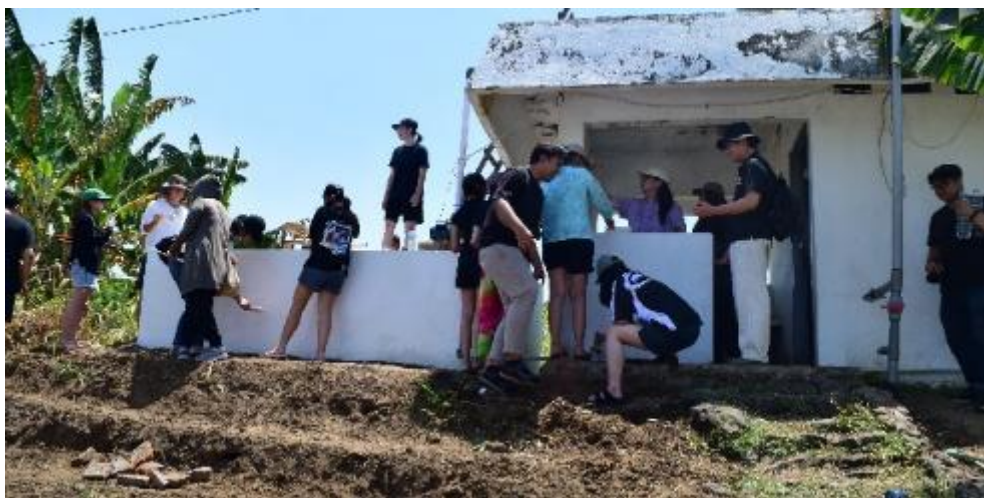
Gambar 4. Pengecatan Ruang Pompa
