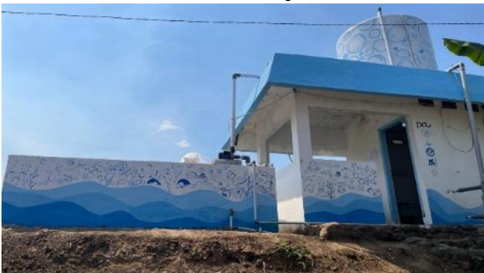
Gambar 6. Mural di Ruang Pompa
