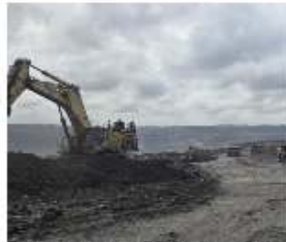
Gambar 6. Proses perbaikan sisa material ( spoil ) di tepi jalan
