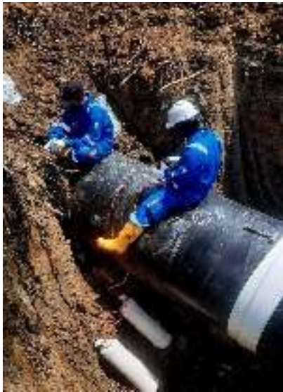
Gambar 5. Pemasangan Anoda di lapangan
