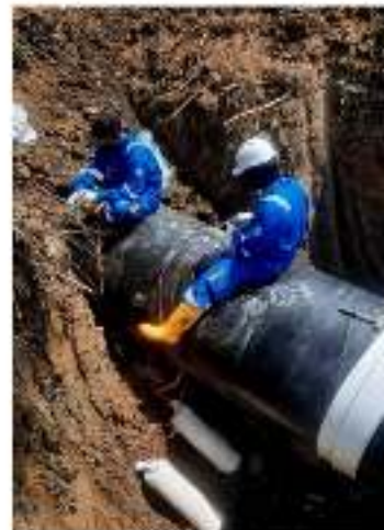
Gambar 5. Pemasangan Anoda di lapangan
