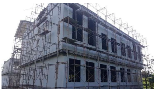
Gambar 4. Tampak Bagian Luar Bangunan
