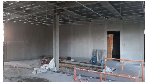
Gambar 5. Tampak Bagian Dalam Bangunan
