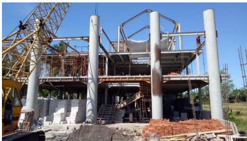
Gambar 2. Tampak Depan Bangunan
