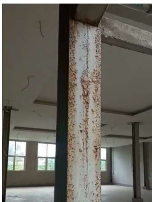
Gambar. 7. Baja Bagian Dalam Berkarat
