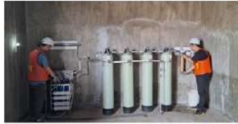
Gambar 3. Pemasangan dan penjelasan alpamal di lokasi
