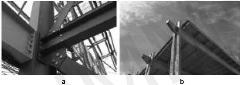
**Gambar 2.1** (a) *Joint Bolt* Baja dan (b) *Joint Kayu*
