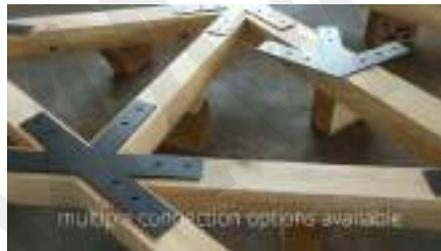
**Gambar 14.7** Pelat Penghubung pada Konstruksi Kuda-kuda
