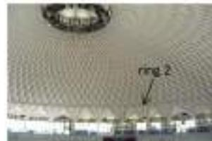
**Gambar 15.4** Rib-rib dan Ring pada Struktur Shell Kubah Palazzetto Dello Sport
