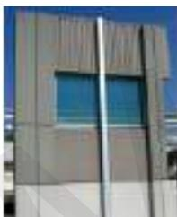
**Gambar 14.117** Panel Beton Pracetak dengan *Finishing* Garis dan Polos
