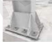
**Gambar 14.59** Angker *Base-Plate* Kolom
