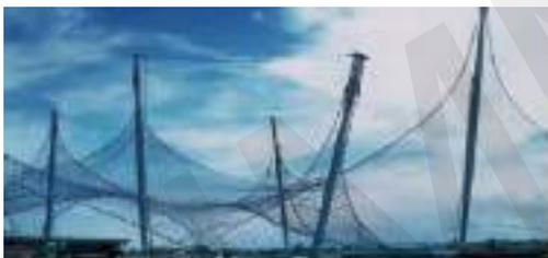
**Gambar 15.10a** Struktur Kabel dan Jaring
