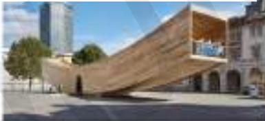
**Gambar 14.42** Struktur *Cantilever Box CLT the Smile* salah Satu Proyek *Landmark* di Jerman Festival
