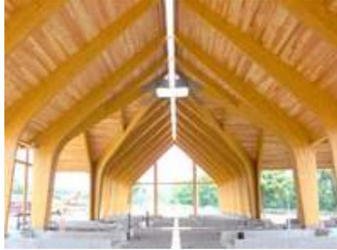
**Gambar 14.31** Gable Frame dengan Sudut Lengkung *Gluelam*
