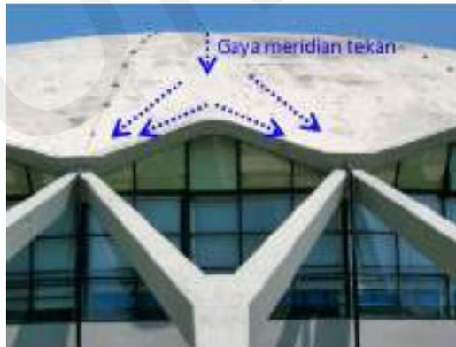
**Gambar 15.7** Penyaluran Gaya pada Lipatan Tepi *Shell* Palazzetto Dello Sport
