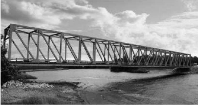
**Gambar 8.7a** Struktur Rangka Batang Baja
