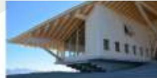
**Gambar 14.43** Struktur Campuran Dinding Pemikul dan Rangka CLT
