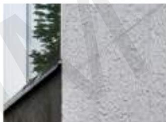
**Gambar 14.118** Panel Beton Pracetak dengan *Finishing* Permukaan Kasar
