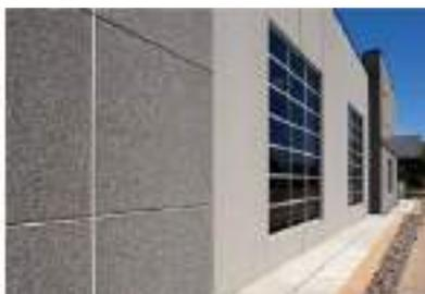
**Gambar 14.119** Panel Beton Pracetak *Finishing* Granit pada Sebuah Bangunan
