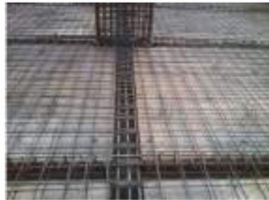
**Gambar 14.87** Tulangan Terpasang di atas Bekisting Pelat dan di dalam Bekisting Balok
