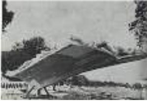
**Gambar 15.1** Uji beban pada Shell Hypar
