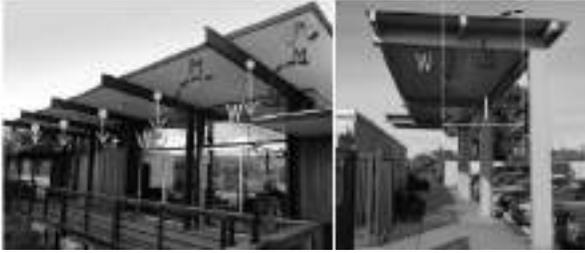
**Gambar 3.5** Kantilever pada Kanopi
