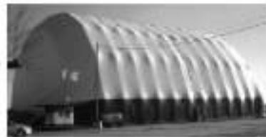
**Gambar 10.9** Struktur Membran *Pneumatic Air-Inflated* dengan Kover Eksternal
