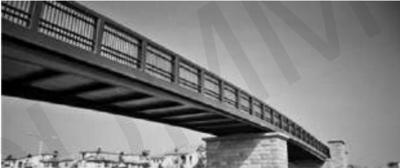
**Gambar 8.7b** Struktur Vierendeel Baja
