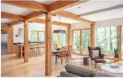
**Gambar 15.13** Balok Kayu Diletakkan pada Sumbu Kuat, Kekakuan Tekuk Kolom ke Dua Arah Sumbu Sama (Penampang Bujur Sangkar)
