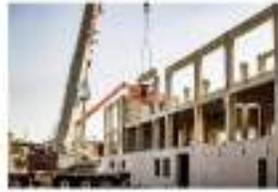
**Gambar 14.102** Pelaksanaan Perakitan Kolom dan Balok Beton Pracetak
