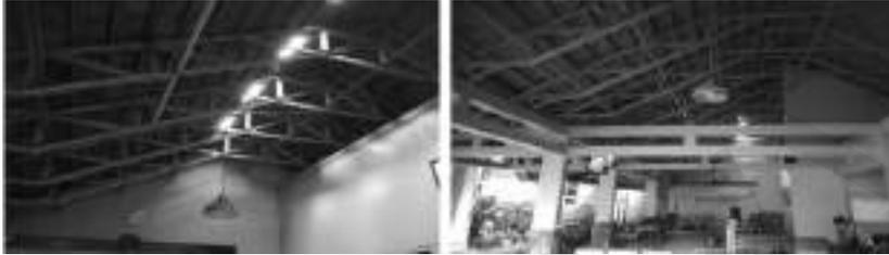
**Gambar 8.9** Struktur Rangka Batang dengan Bahan Baja Ringan
