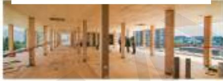
**Gambar 14.47** Struktur *Post-Plate* CLT
