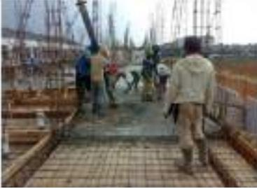
**Gambar 14.88** Pengecoran Pelat dan Balok
