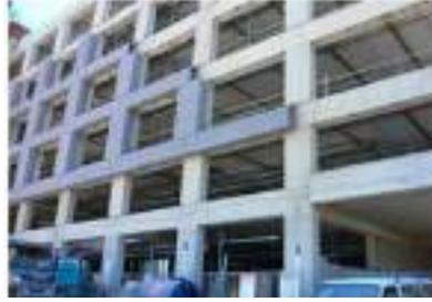
**Gambar 14.89** Contoh Bangunan Bertingkat Banyak Beton Bertulang *In-Situ*
