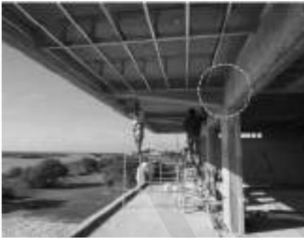
**Gambar 4.10** Join Kaku pada Kolom – Balok Beton Bertulang
