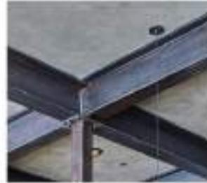
**Gambar 15.14** Balok Baja I Diletakkan pada Sumbu Kuat, Kekakuan Tekuk Kolom *Hollow Square Section* (HSS) ke Dua Arah Sumbu Sama
