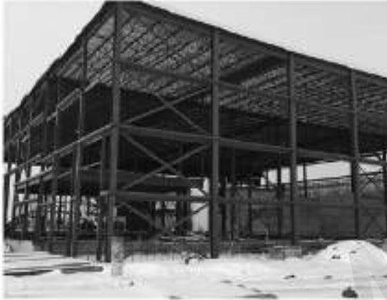
**Gambar 8.13a** *Frame dan Bracing*
