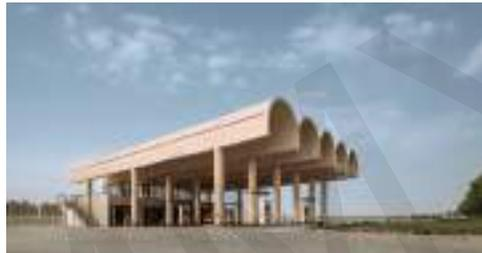
**Gambar 13.18** Long *Barrel Shell* dengan Pengaku Balok “Vertikal”
