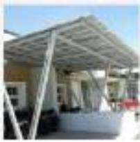
**Gambar 14.74** Baja Ringan untuk Kanopi
