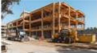
**Gambar 14.46** Struktur Rangka dengan *Bracing* CLT
