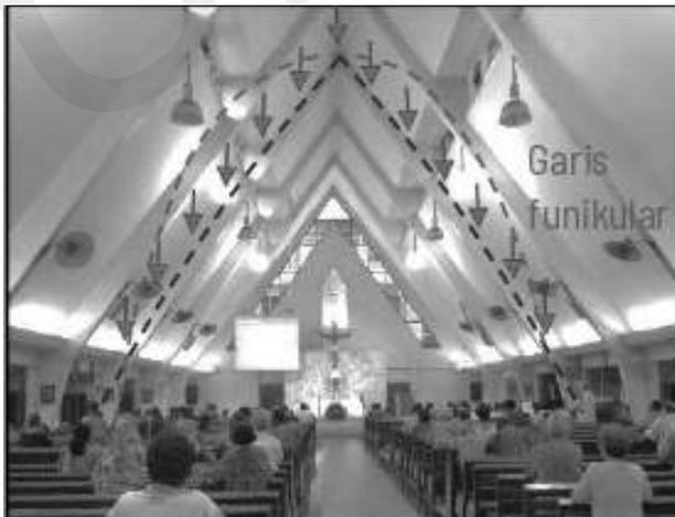
**Gambar 2.11** Bentuk *Semi Form Active* yang Menyerupai Garis Parabola
