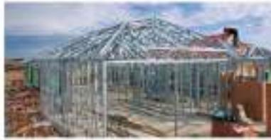
**Gambar 14.74** Baja Ringan untuk Bangunan 1 Lantai
