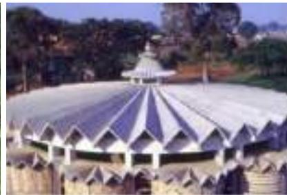
**Gambar 12.20** Struktur Atap Pelat Lipat Beton Bertulang Radial
