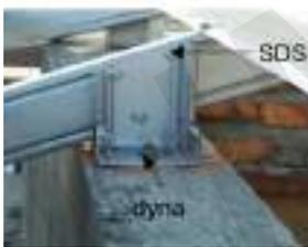
**Gambar 14.72** Detail Pertemuan Kuda-Kuda dengan Ring Balk
