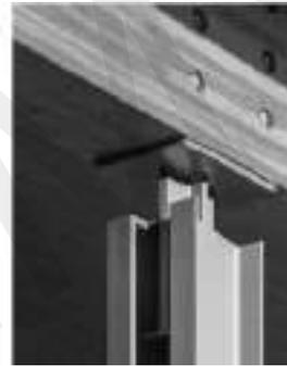
**Gambar 4.11** Join Sendi pada Kolom Baja – Balok Kayu
