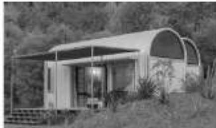
**Gambar 13.6** Barrel Vault Pelat Baja Gelombang
