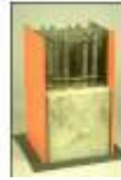
**Gambar 14.51** Perlindungan Terhadap Kebakaran dengan Cor Beton
