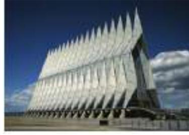
**Gambar 12.22** Struktur Pelat Lipat Rangka Baja
