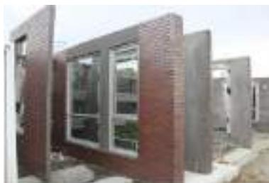
**Gambar 14.115** Panel Beton Pracetak dengan *Finishing* Bata
