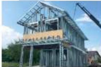
**Gambar 14.75** Baja Ringan untuk Bangunan 2 Lantai
