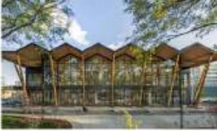
**Gambar 12.21** Struktur Atap Pelat Lipat Kayu (DLT\*)
