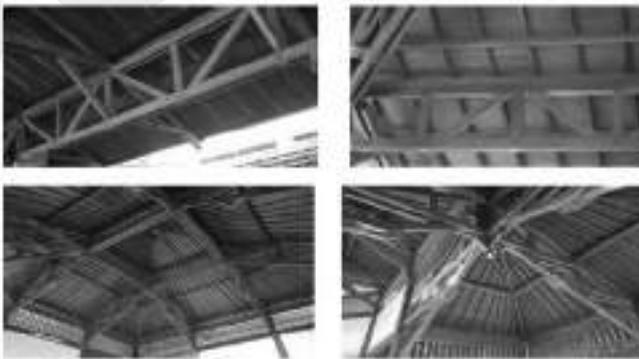
**Gambar 8.3** Contoh Rangka Batang dengan Bahan Kaku (Material Kayu)
