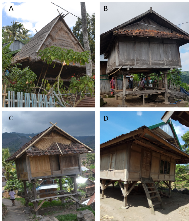
Fig. 1 Typology of Bima vernacular architecture: uma lengge (A), uma mbolo (B), uma jompa (C), uma pangu (D)
