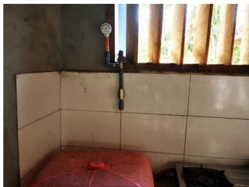
Gambar 7. Peletakan manometer
