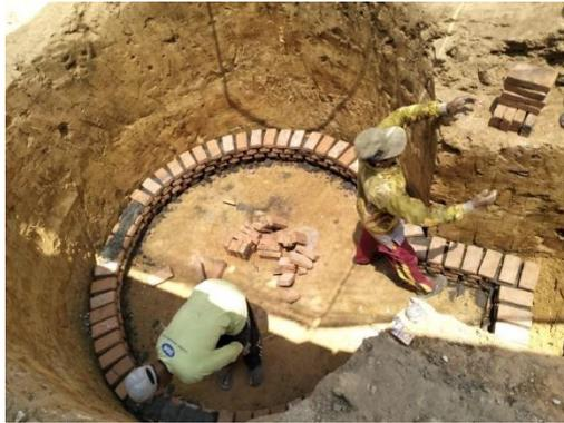
Gambar 3. Proses pembuatan pondasi
