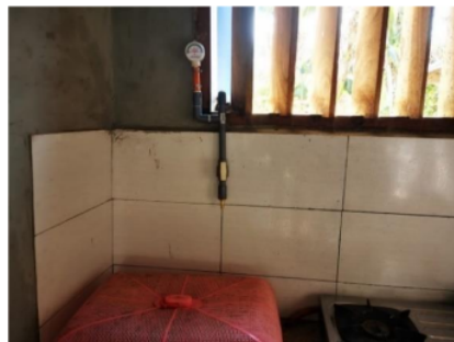
Gambar 7. Peletakan manometer
