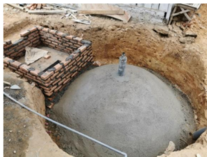
Gambar 4. Proses pembuatan kubah yang bagian atasnya dilengkapi dengan pipa besi
