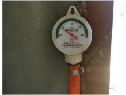
Gambar 8. Jarum manometer yang naik mengindikasikan adanya gas yang siap digunakan
