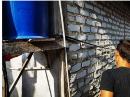
Gambar 6. Proses pemasangan sistem perpipaan
