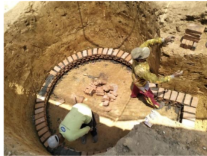
Gambar 3. Proses pembuatan pondasi
