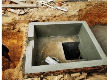
Gambar 5. Proses pembuatan saluran keluar sisa proses biogas ( slurry )
