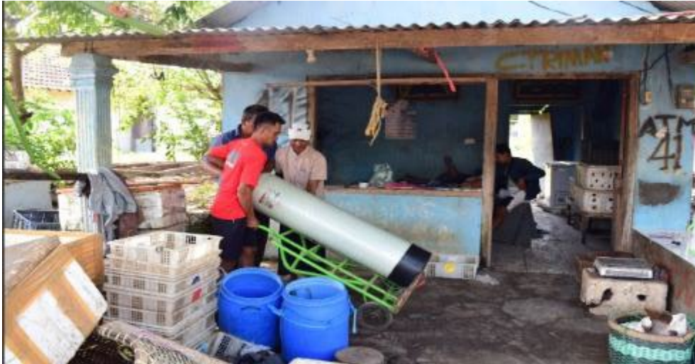
Gambar 2. Pemasangan ALPAMAL pada rumah warga
