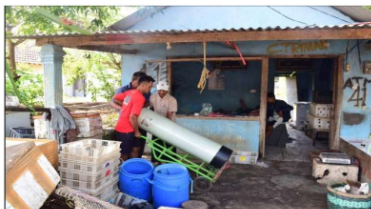
Gambar 4. Pemasangan ALPAMAL pada rumah warga
