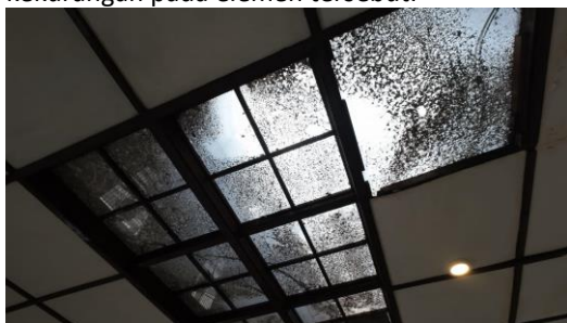
Gambar 2. Plafon yang Kurang Terawat [Sumber: Dokumentasi Penulis 2025]
