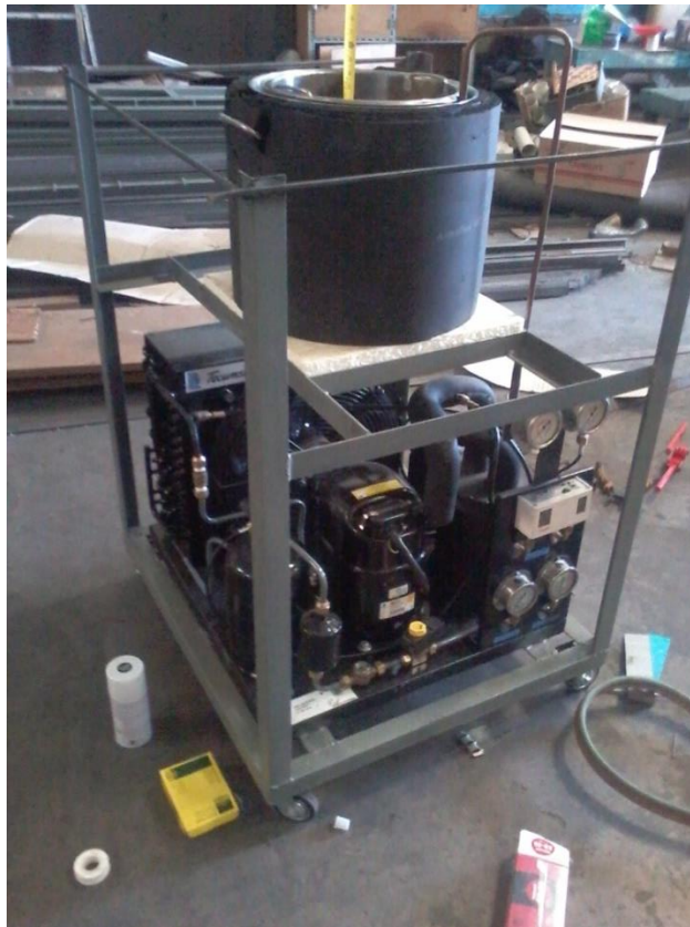
Gambar 5.20 Pembuatan dan pemasangan kerangka untuk evaporator
