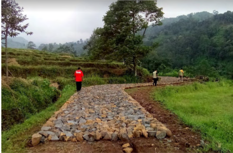
Gambar 2.10 — Akses jalan beraspal sebagai konektor yang menghubungkan desa dengan area pasar
