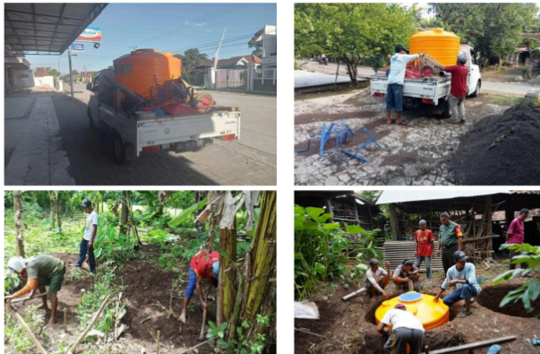
Gambar 2. Proses Pengadaan Alat, Bahan, dan Pemasangan Tabung Penyimpan Kotoran Sapi Untuk Biogas
