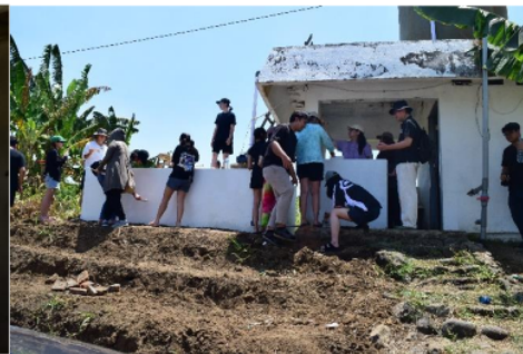
Gambar 4. Pengecatan Ruang Pompa
