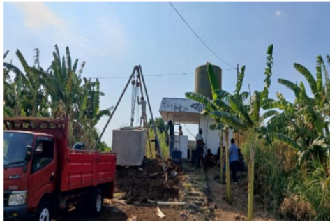
Gambar 5. Pemasangan Tandon Air
